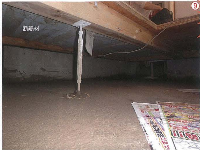
⑨ 上は、越水した若宮戸地区に建つ築10年の住宅。床上すれすれまで浸水した。ベタ基礎の床下にたまった泥をかき出すため、点検口を3カ所新たに設け、床下を扇風機で乾かしていた。コンクリートと床の断熱材の表面に、土がうっすら残る。左上は、ぬれてのりが剥がれ、下端が膨らんでいるMDF製の室内引き戸
