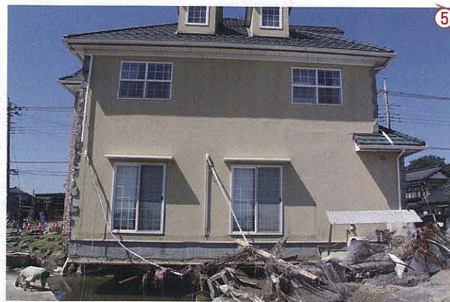
比較的新しい2階建て住宅は、外周部の地盤が大きく失われていたが、不同沈下や上部構造の被害は外観上なかった。地盤と基礎に詳しいミサワホーム総合研究所担当部長の松下克也さんは「ベタ基礎は下が平坦なので、布基礎より地盤は流されやすい可能性がある」と話す
