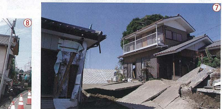
右側は決壊した堤防のすぐ近くに建つ住宅。約1.5m浸水したものの、比較的軽微な被害にとどまっていた。東京大学の芳村さんは「前面道路がアスファルトで舗装されていたので、建物直下の地盤が洗掘されにくくなっていたかもしれない」と話す
