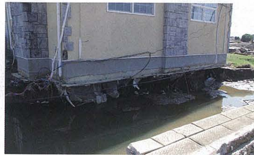
比較的新しい2階建て住宅は、外周部の地盤が大きく失われていたが、不同沈下や上部構造の被害は外観上なかった。地盤と基礎に詳しいミサワホーム総合研究所担当部長の松下克也さんは「ベタ基礎は下が平坦なので、布基礎より地盤は流されやすい可能性がある」と話す
