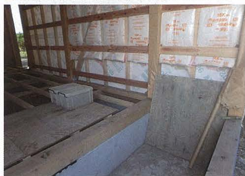
⑨の手に並び建設中の別棟。床上すれすれまで浸水したので、大工が断熱材の下端を切り取り、乾かしていた。基礎パッキンにも泥が付いて、通気を塞いでいた (写真:下は金井工務店)
