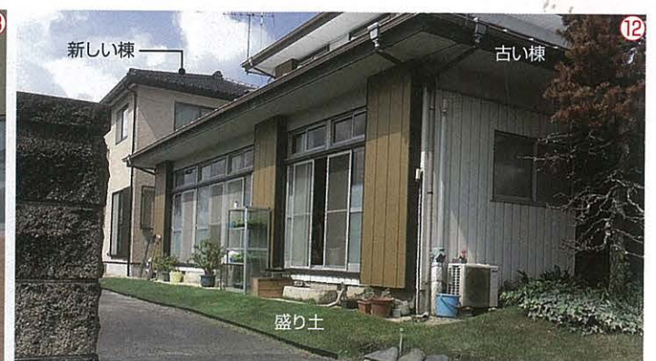
12 東京大学沖・芳村研究室が居住者にヒアリングした常総市上蛇町に建つ住宅。先祖からの教えで地盤を道路より少し上げていた。道路は約80cm浸水していたが、奥に見える新しい棟は床下浸水にとどまった。それより基礎高が約3cm低かった手前の古い棟は、わずかがだが床上浸水した(写真:東京大学沖・芳村研究室)
