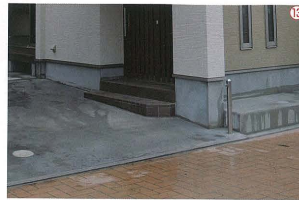
13 建て主の希望で、道路より地盤が高くなるよう、基礎工事で掘った土を使って盛り土していた常総市内の住宅。浸水した住宅は周囲に少ないが、この住宅は通気パッキンより浸水深が低かったため、建物内への浸水を免れた。船本建築設計事務所(常総市)が設計し、田島工務店(同)が施工を手掛けた(写真:田島工務店)
